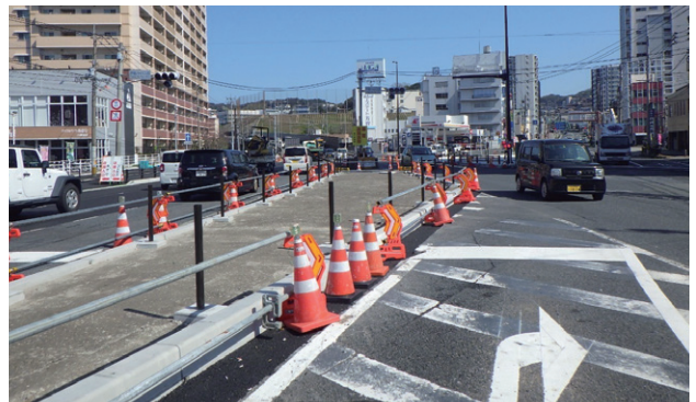
設置前の工事風景
