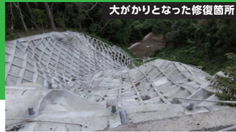
大がかりとなった修復箇所
