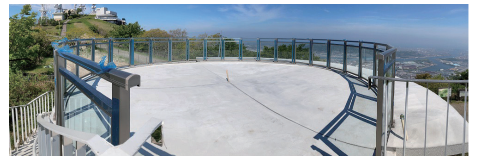
約2年工事が中断している皿倉山天空ドーム、工事再開間近に！
