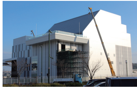
完成間近な新科学館外観
