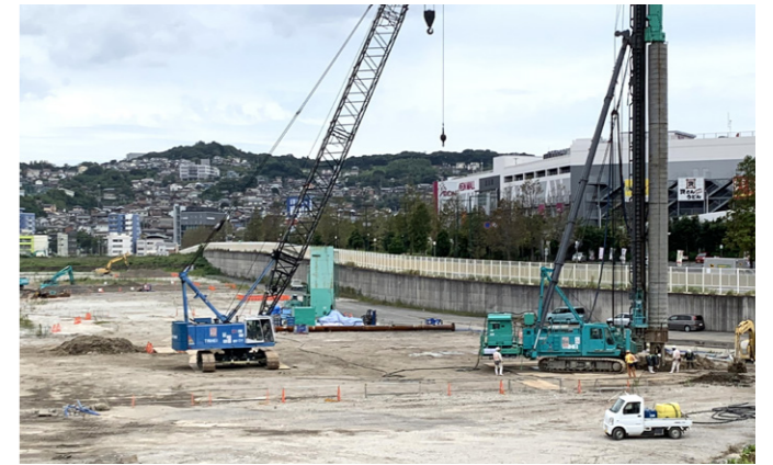
アウトレットオープンに向け急ピッチで進む工事
