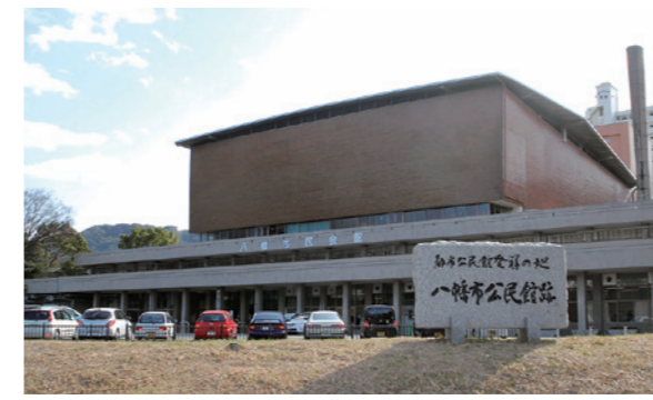
今後の利活用の判断が待たれる旧八幡市民会館
