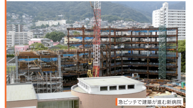
急ピッチで建築が進む新病院
