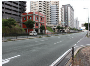
今まで歩道整備がなく、度々危険な横断が見られた問題箇所
