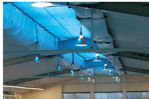
天井部分の腐食したサビなどの落下防止の為にブルーシート
